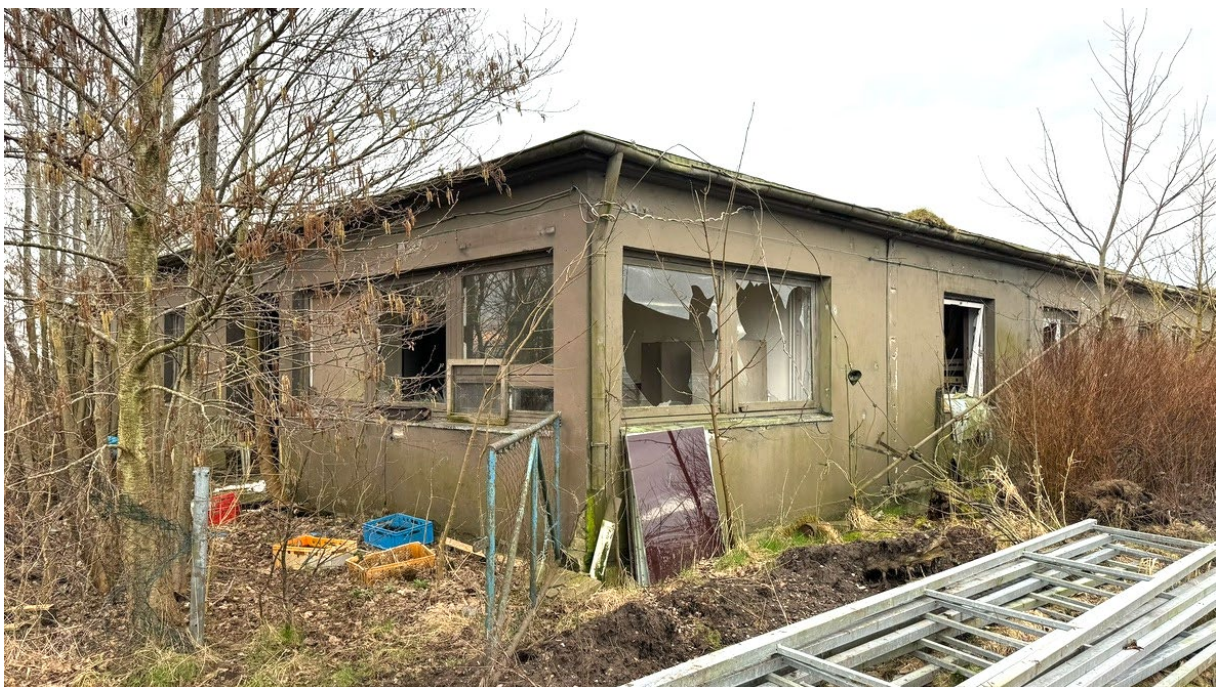
Abb. 7: Außenansicht des ehem. Wohngebäudes. Aufnahme: 01.03.2024
