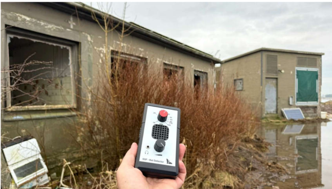
Abb. 8: Überprüfung der Außenmauern von zwei Gebäuden auf Fledermausquartiere mit dem Detektor. Aufnahme: 01.03.2024
