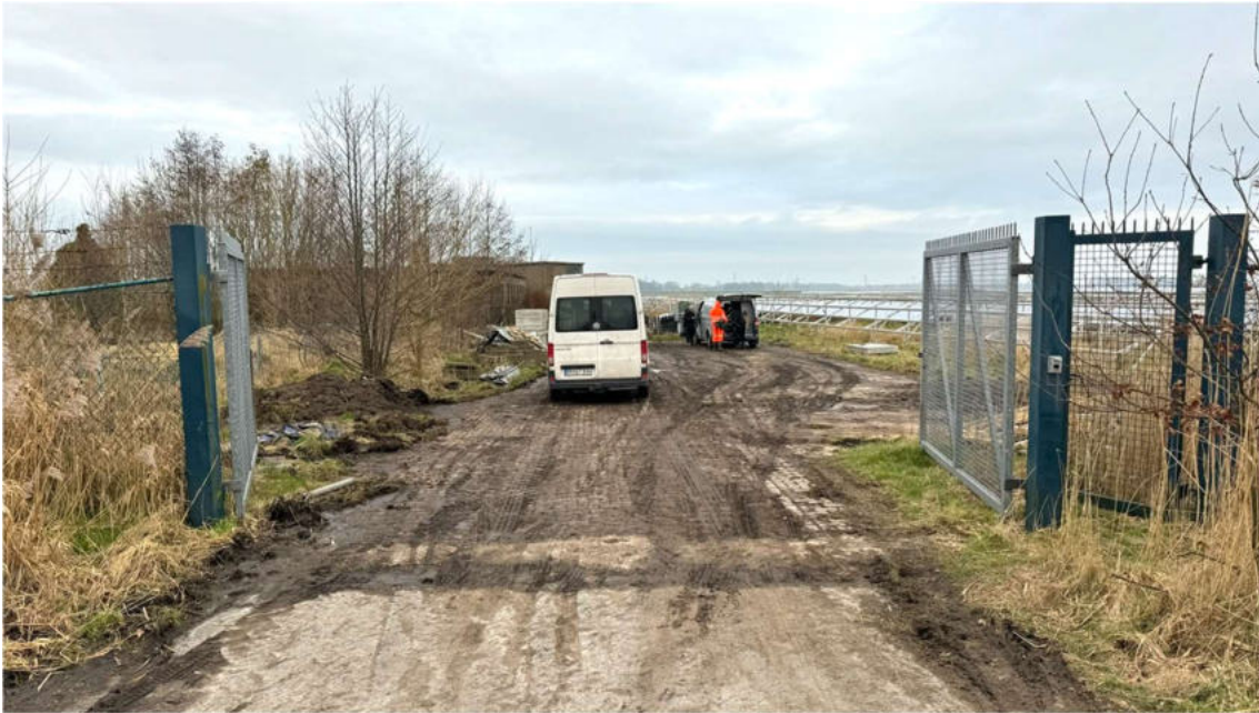
Abb. 7: Zugang zur PV-Anlage und den beiden sich darauf befindlichen Gebäuden. Aufnahme: 01.03.2024
